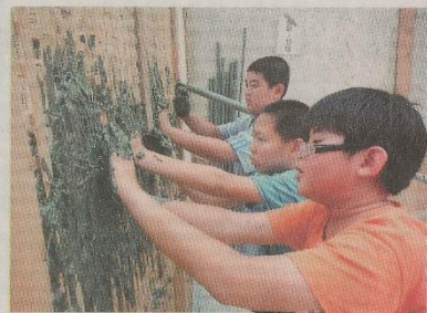
新東國小學童參與歷史建築物編竹夾泥牆修復工程，認識古早建物構造。(記者王涵平攝)
